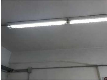
I corpi illuminanti hanno adeguate protezioni contro la possibile caduta delle lampade. Le parti in tensione non possono essere raggiunte se non con l'ausilio di un attrezzo
