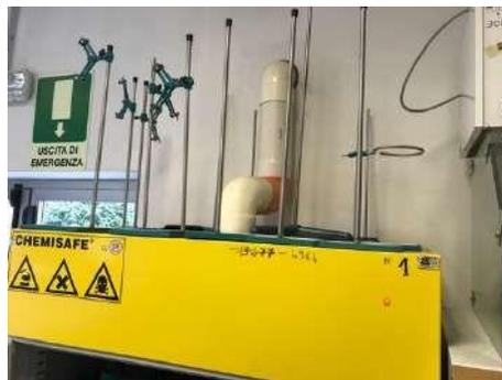
Presente banco di lavoro dotato di cappa aspirante con espulsione dei vapori all'esterno dell'edificio
