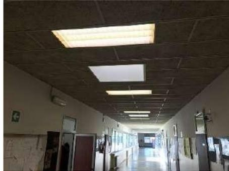
Presenti corpi illuminanti a soffitto in tutti i locali che consentono una adeguata illuminazione artificiale in caso di bisogno. I corpi illuminanti hanno adeguate protezioni contro la possibile caduta delle lampade. Le parti in tensione non possono essere raggiunte se non con l'ausilio di un attrezzo
